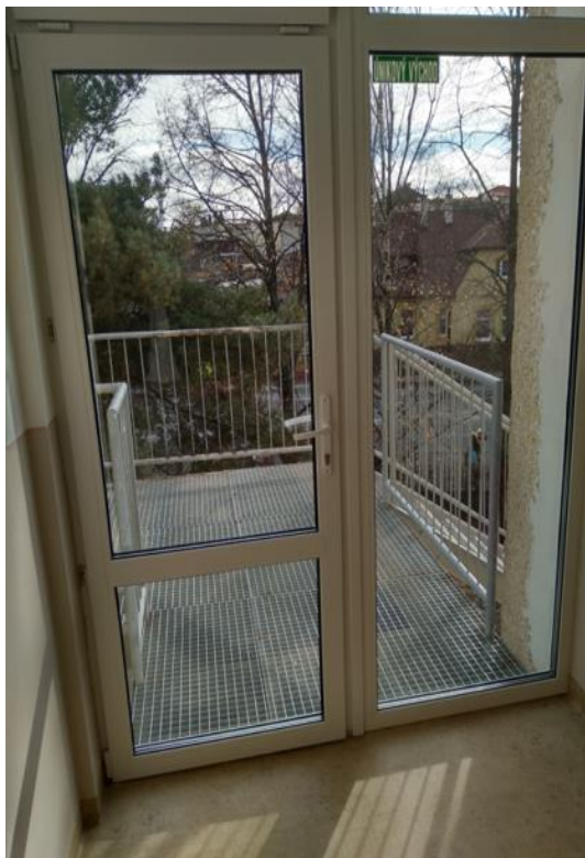
Zlepšenie protipožiarňých opatrení – vybudovanie 2. únikového východu z oddelenia a protipožiarneho schodiska
