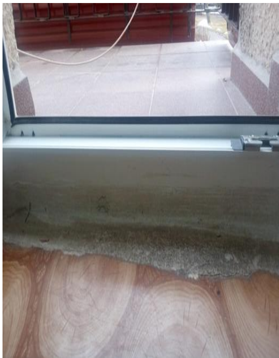
Pôvodný stav – bariéra na izbe klientov – vstup na balkón
