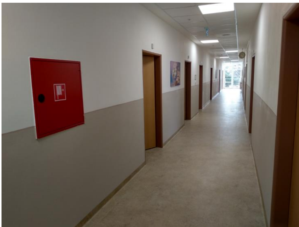
Vybudovanie hydrantu na oddelení C2
