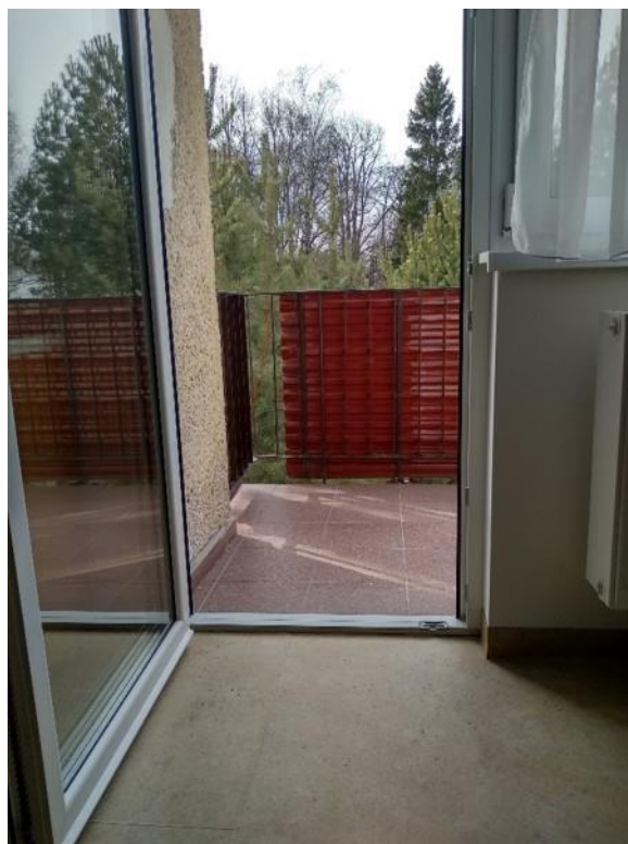
Nový stav – vstup na balkón
