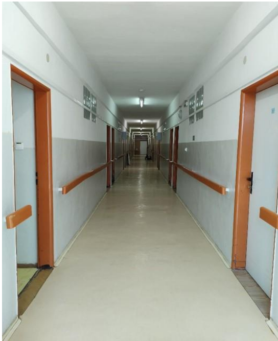
Pôvodný stav – chodba C1 oddelenia
