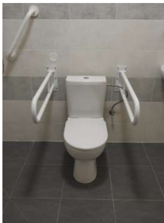
Nové bezbariérové WC
