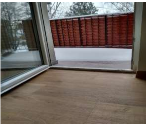
Nový bezbariérový vstup na balkón
