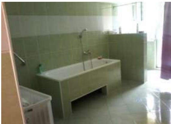
Pôvodne – jedna kúpeľňa vrámci chodby
